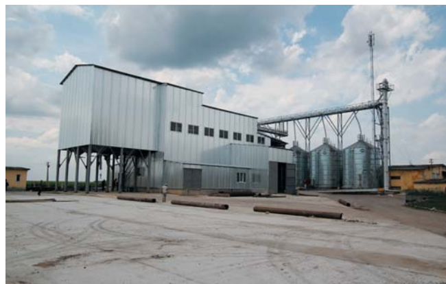
Фото 5. Нещодавно завершений комбикормовий завод проектною потужністю 10 т/год. (200 т /доба) буде обслуговувати всі напрями тваринництва корпорації
