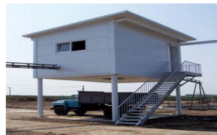
Фото 1. Будівля для розподілу сепаратором рідкого гною, обробленого реагентами, на фракції. Рідка фракція передається на обробку в біореактор, а механічно зневоднений осад транспортують на компостувальний майданчик.
