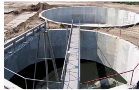
Фото 5. Біореактор для господарства із відгодівлі 11900 свиней/рік – бетонна ємність висотою 5м та 9м у діаметрі. За 7-10 днів рідка фракція перетвориться на біологічно очищені стічні води без запаху, придатні для витримання в біоставках.
