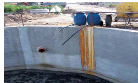
Фото 2. Додавання реагентів в приймальну камеру залпового скиду виробничих стічних вод (рідкого гною) попереджує виділення неприємних запахів.
