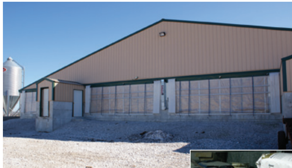
Завіси, які дозволяють додатково вентилювати приміщення у спекотні періоди року (фото із колекції New Modern Concepts)
