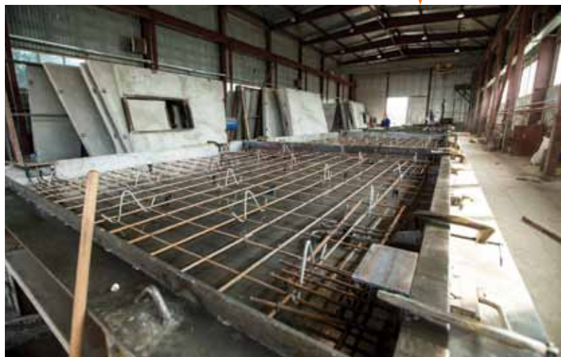
Бетонний вузол Фото 7.
