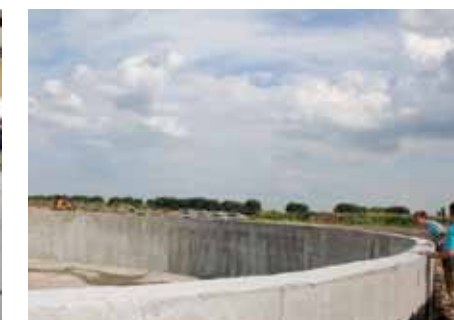
↑ Одна з чотирьох суцільнобетонних лагун
