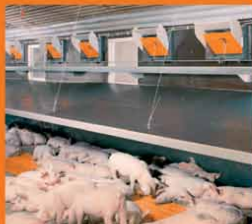
Приточна вентиляція з опаленням
