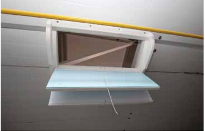
Фото 8. Двосторонні клапани для подачі повітря у бокси
