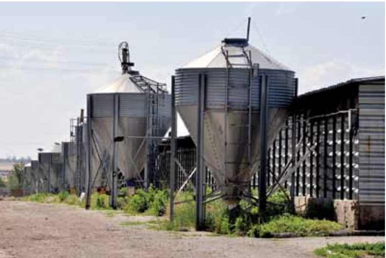
Бункери на дорощуванні: кожен на 12 т корму Фото 1.
