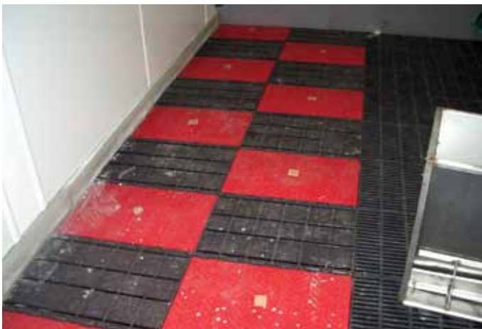
Фото 7. Комбінування елементів щілинної підлоги та водяних панелей підігріву по-японськи
