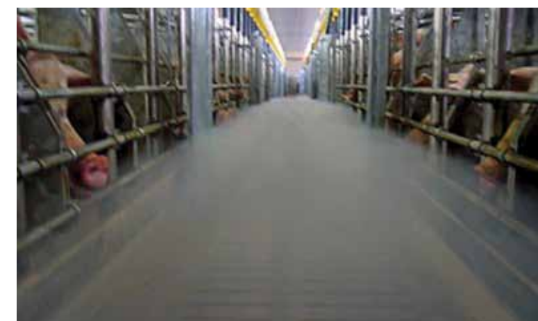
Фото 5. Охоложене повітря, зафарбоване «дискотечним» димом, рівномірно підіймається до кліток із тваринами
