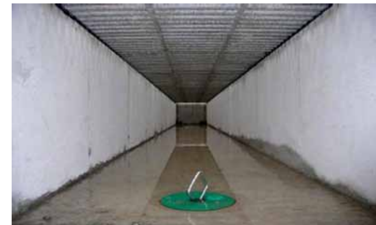
Фото 4. Вентиляційна шахта для подачі повітря з-під підлоги
