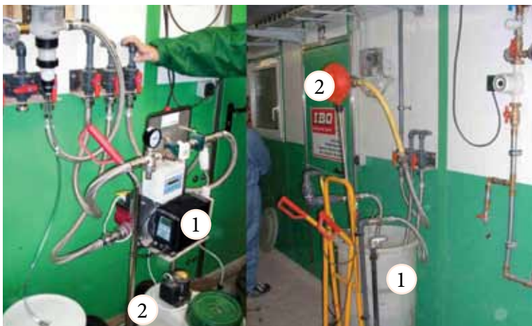
Фото 4, 5. Оснащення для подачі води у водогін
