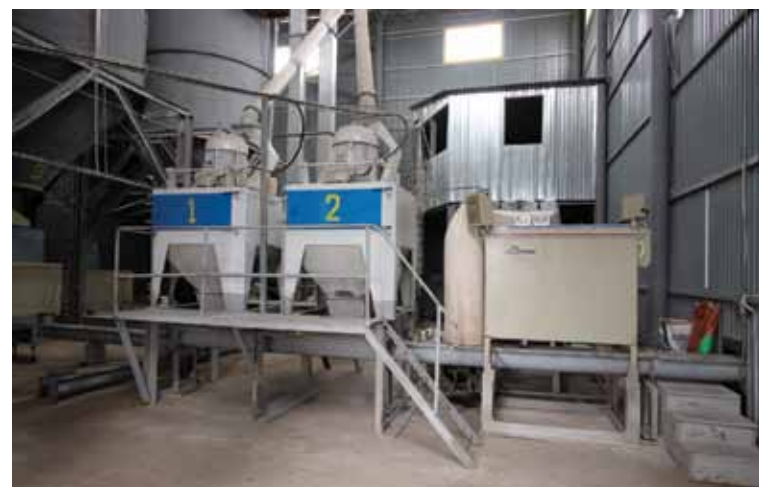
Тривають останні підготовчі роботи для відкриття комбікормового заводу, що готуватиме 150 тонн корму щодня
