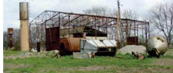
Фото 3. Ідеальний майданчик: каркас будівлі, що стоїть відокремлено, поруч свердловина та трансформаторна підстанція
